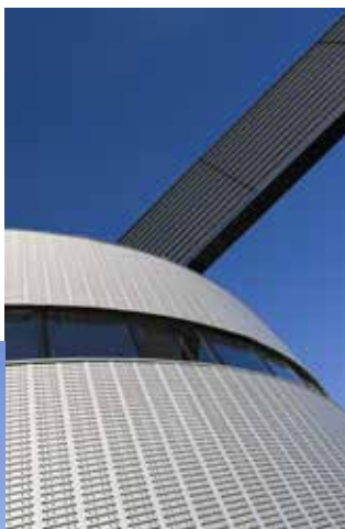
Pôle agro-alimentaire Lyon Corbas (69) 50 000 m 2 bâtiment logistique maître d'ouvrage : SNC Corbas développement
